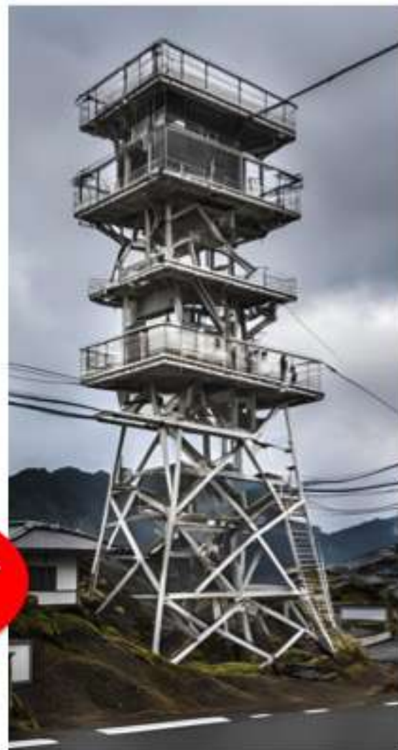
津波避難タワー
