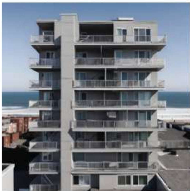
津波避難ビル
